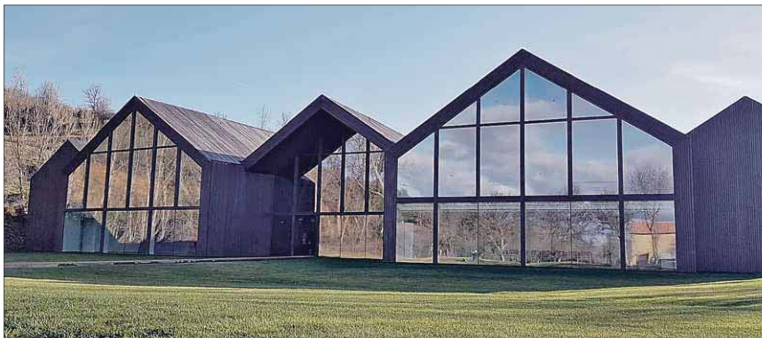
Imagen del edificio de la Fundación Cerezales Antonino y Cinia. CASTRO
