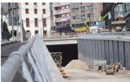
Ejecución del túnel de Romero Donallo en el 2005. P. R.
